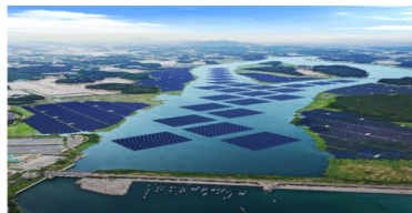
보령호 태양광 집적화단지 (2023~2025, 300MW)
